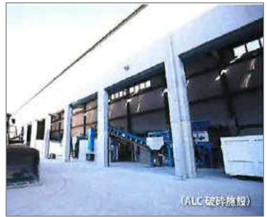
破碎・切断施設
