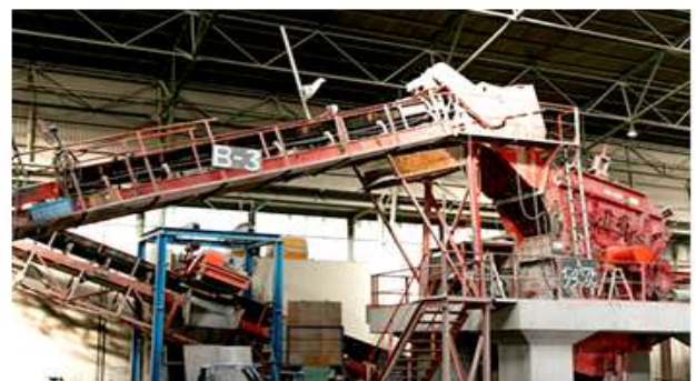
二次破碎機（インパクトクラッシャー） 磁力選別機（マグネットクラッシャー）
